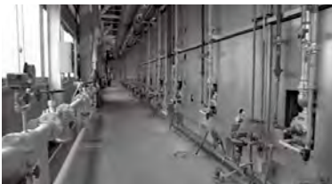
立風製陶(株) 2001年に完成した世界最大級のトンネル窯(全長108m)
